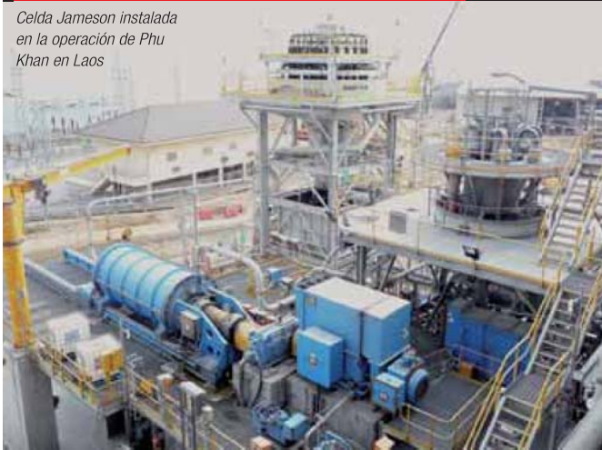
Celda Jameson de acero inoxidable usada para remoción de orgánico en circuito SX-EW, México
